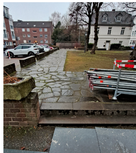
An dieser Stelle wird ein barrierefreier Zugang zum Clemensplatz hergestellt.
